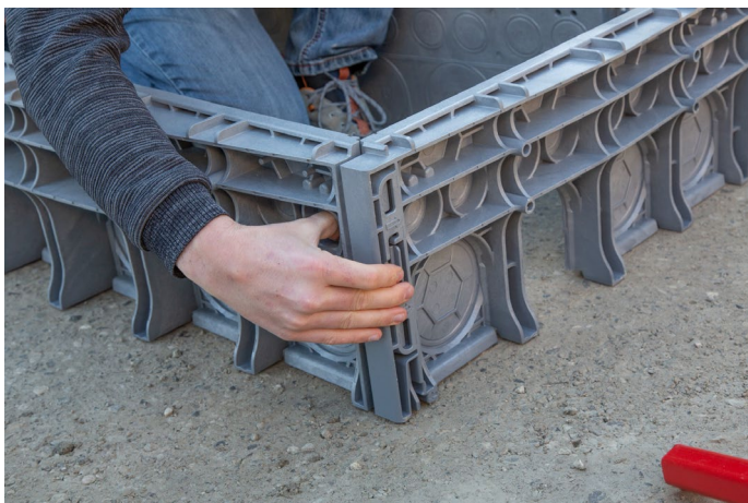
Bild02: Ein integriertes Klicksystem ermöglicht beim neuen XeBo eine schnelle und werkzeugarme Montage direkt auf der Baustelle. (Foto: Langmatz)
